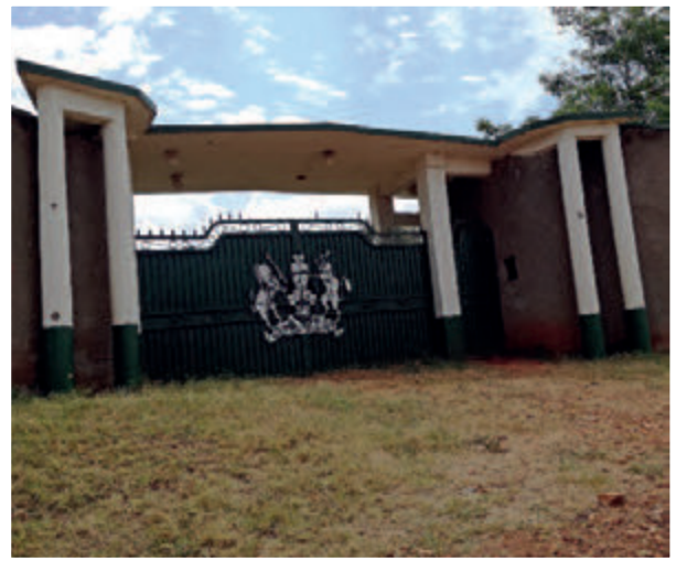
Eingangstor auf das Anwesen des Königs mit deutlichen Einschusslöchern. Das ganze Anwesen ist verschlossen.
