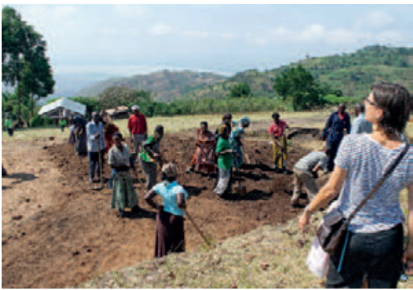
Die Eltern bereiten die Fläche vor, auf der später die neuen Kindergartenräume aufgebaut werden
