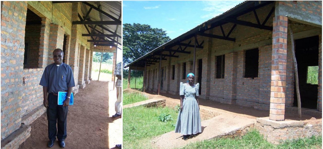
Im Bau befindlicher Kindergarten mit Pfarrer Muwonge und der Stellvertr. CWM Vors. Cecilia
