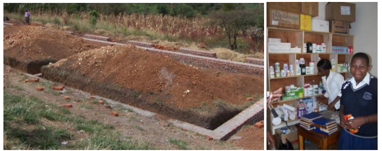
Schulgebäude im Bau)
