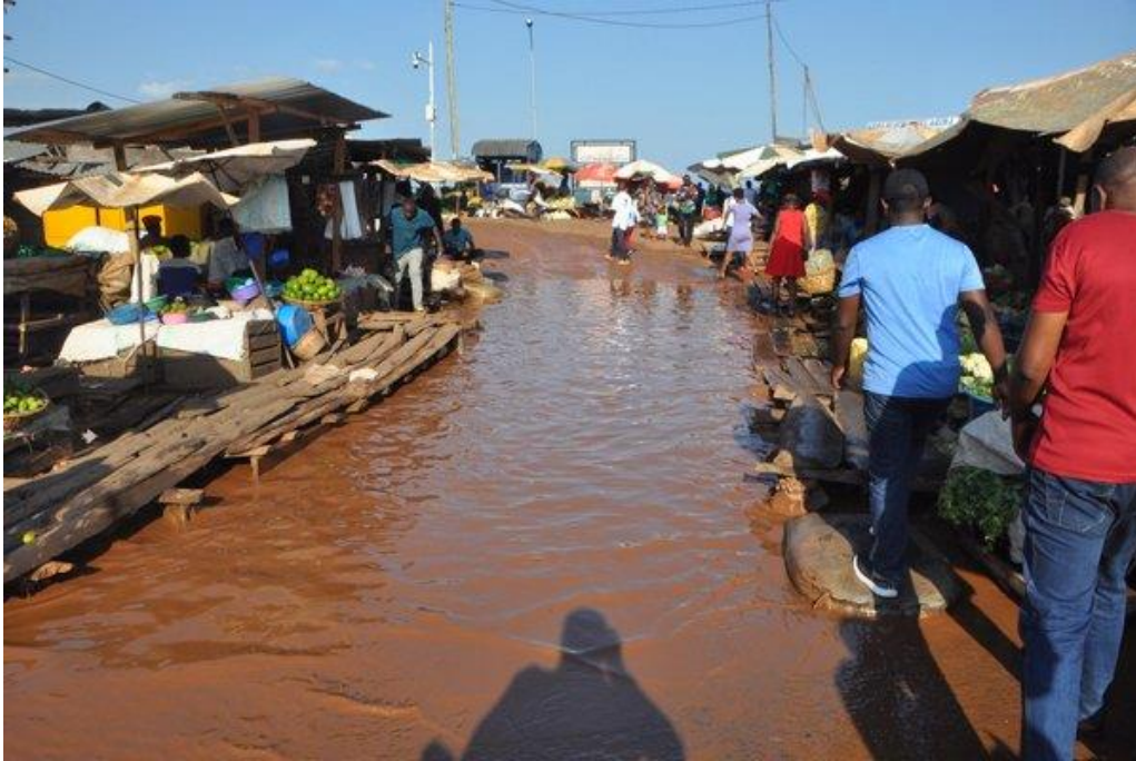
Wasser hat den Ggaba-Markt in Kampala überflutet
